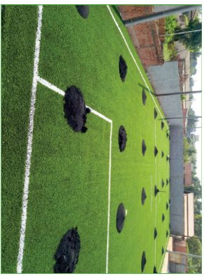
ESPALHAMENTO DE GRANULOS DE BORRACHA
